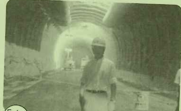
5/30 新幹線大村地区トンネル視察
