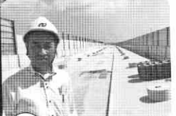
8/1 新幹線建設工事現場視察
